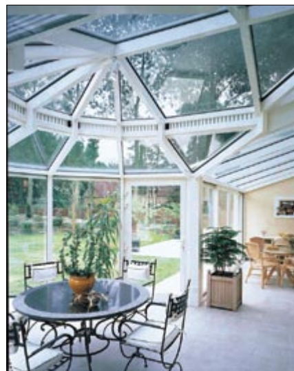
Kratki wentylacyjne w górnej części dachu
