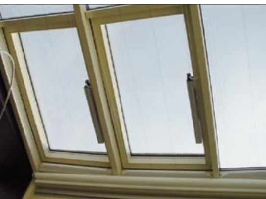
Okno dachowe otwierane elektrycznie
