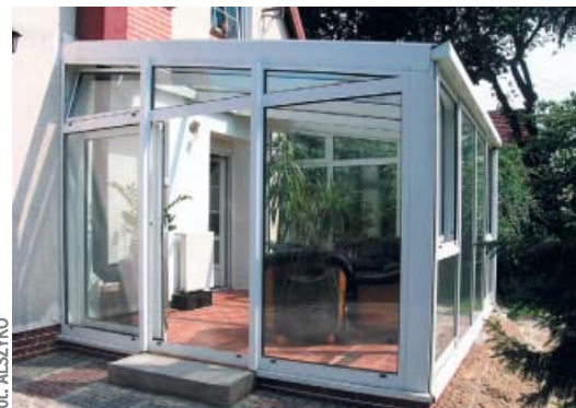
▲ W oranżeriach stosuje się szyby zespolone – powinny być przezroczyste, ale odbijać energię ciepłą
