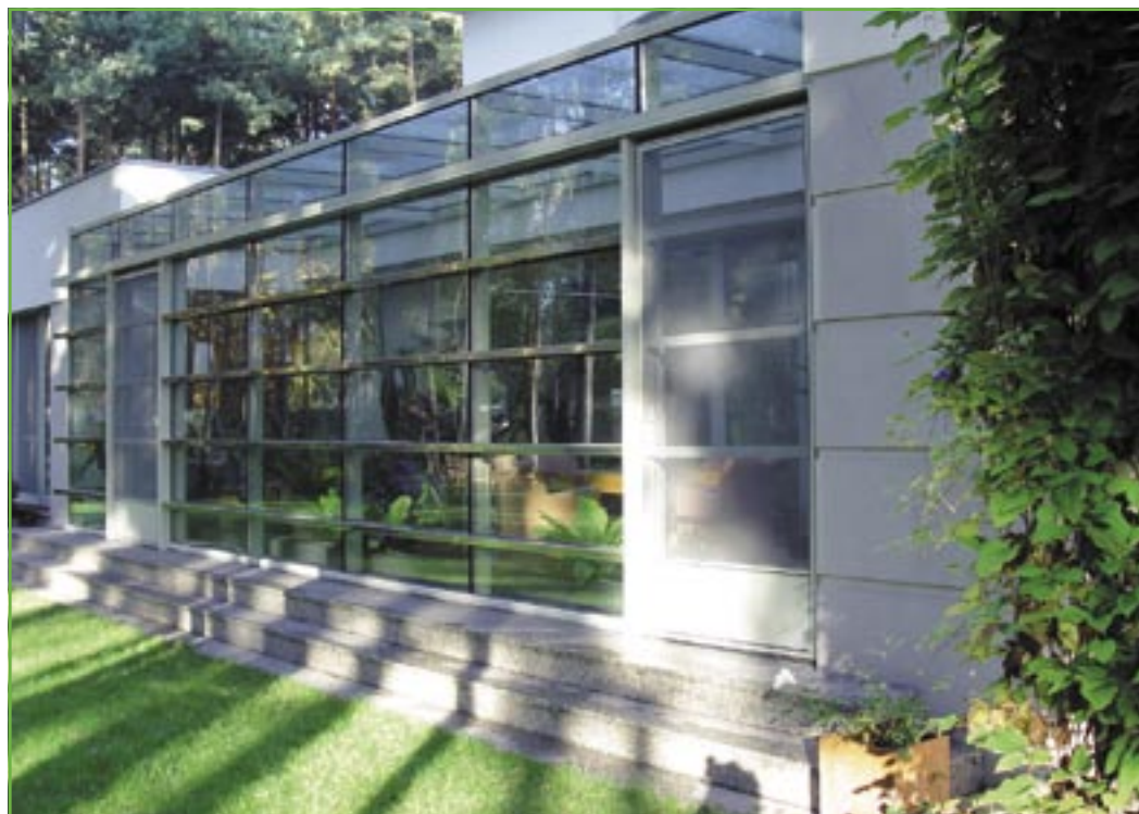
▲ W ogrodach zimowych oferowanych przez firmę Reynaers profile posiadają termoizolacyjne przekładki poliamidowe, które zapewniają doskonałą izolację pomiędzy zewnętrzem ogrodu a jego wnętrzem
